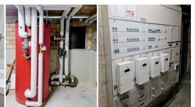
Haustechnik: zentraler Boiler bzw. Hauptverteilung
